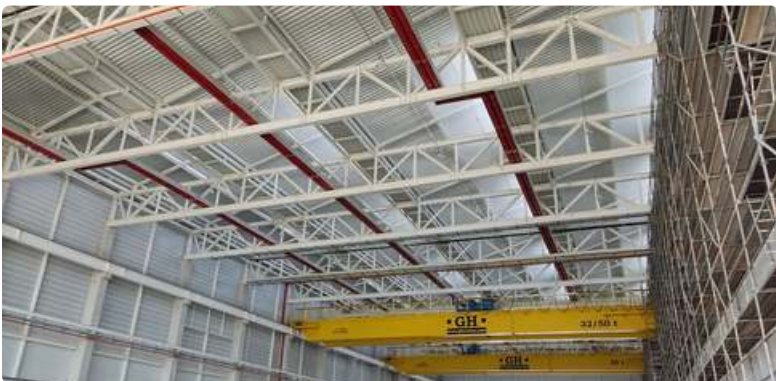
Conductos GIRAD bajo cubierta · Nissan, Ávila, 2021. 17 m de altura media.
