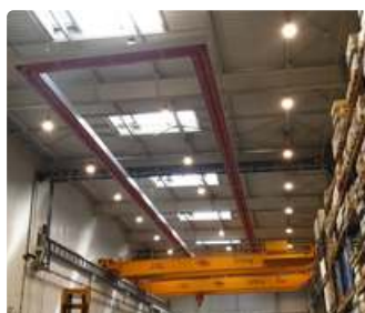
Gamesa · aerogeneradores · Ágreda (Soria) · 2015
